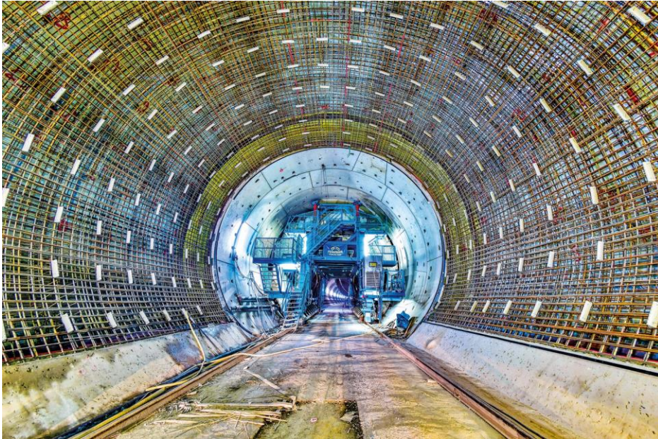
Innovation dans le tunnel de Filder © Arnim Kilgus
