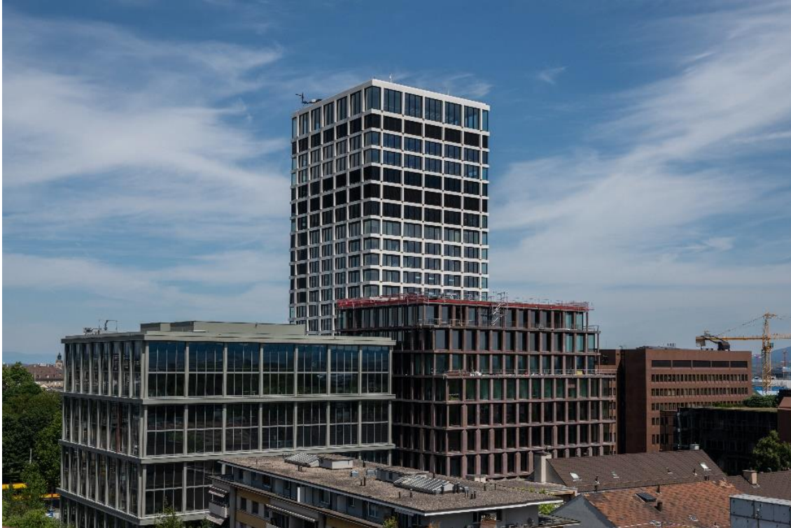
Légende : Le nouveau siège de la Bâloise (à gauche) et le centre de formation (à droite) © PORR
