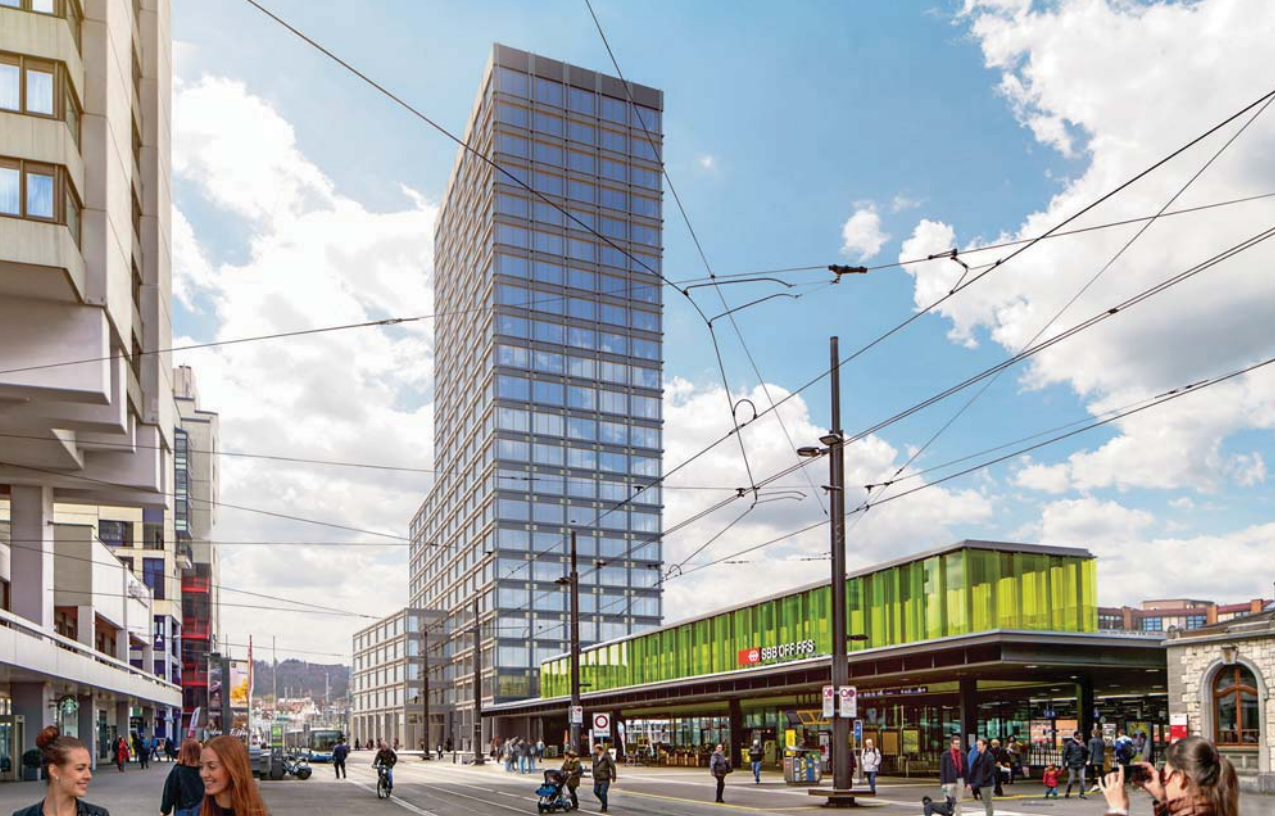
Der Bahnhof in Zürich-Oerlikon mit dem Franklinturm.
