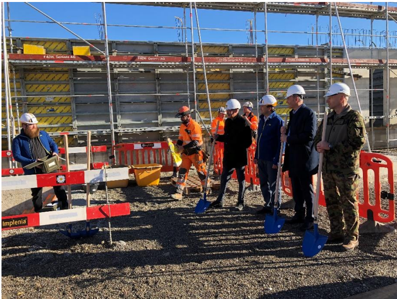
Légende : Premier coup de pioche sur le chantier Ouest. (© PORR)
