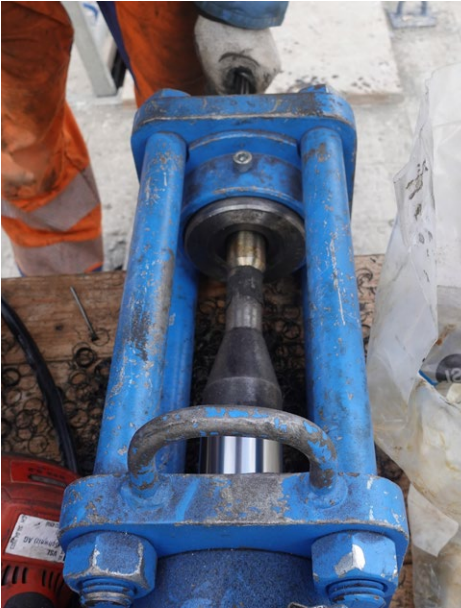
Die Stahlkabel werden für die Fixierung in den Presshülsen vorbereitet.
