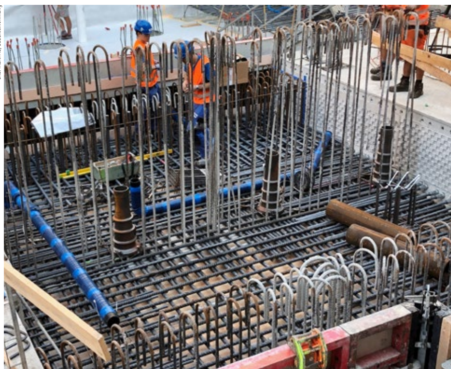
Die Verankerungen der Vorspannung sind in der Bodenplatte im Untergeschoss und in der Decke über dem Erdgeschoss einbetoniert. Die Stahlritzen werden von oben in die Hüllrohre gestossen.
