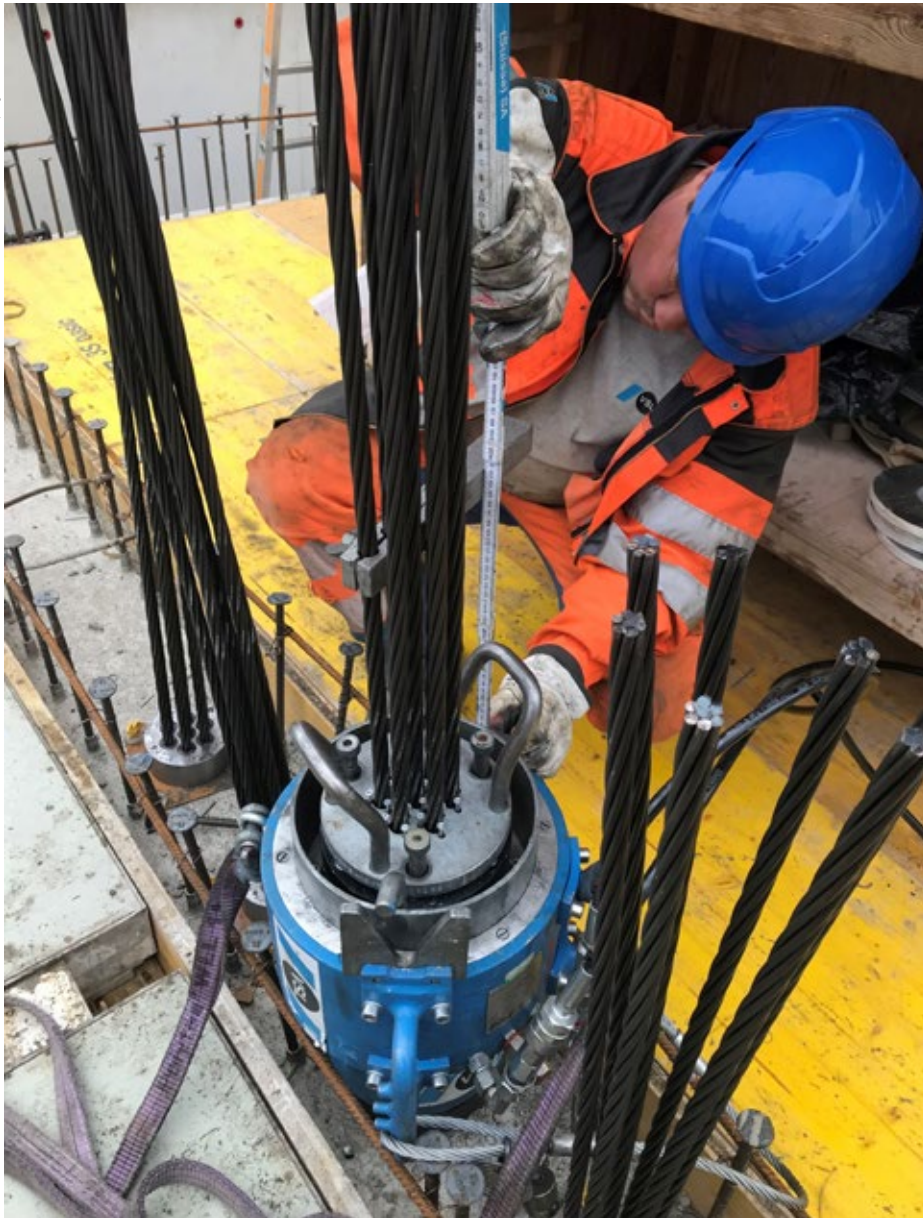
Auf dem elften Stock werden die Litzen mit Spannpressen vorgespannt. Die Kabel werden mit einer Zugkraft von rund 20 Tonnen pro Litze gespannt.
