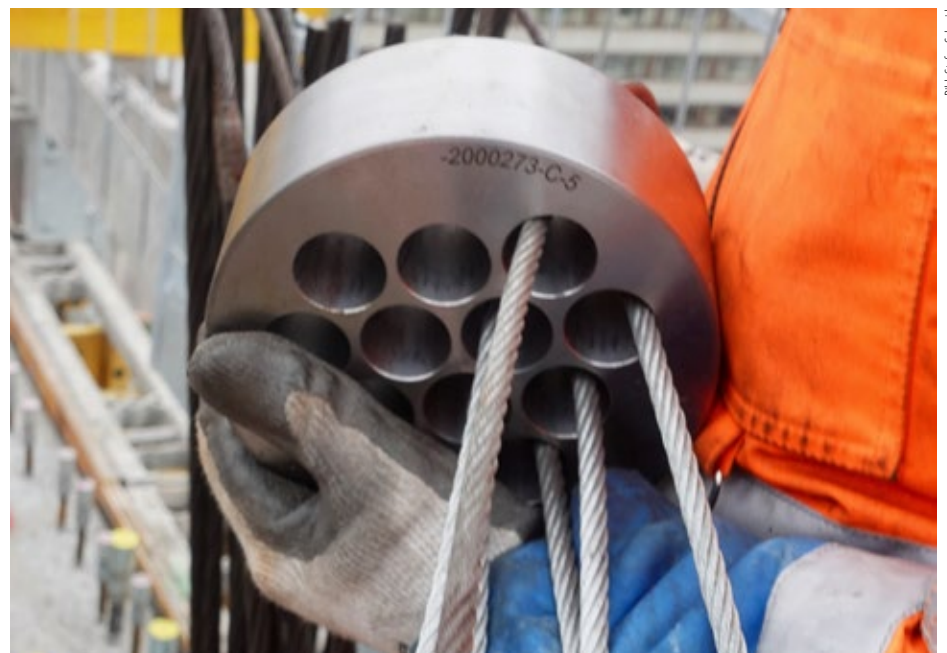
Bei der vertikalen Vorspannung wird die Kraft über die Zahl der eingebauten Litzen gesteuert.
