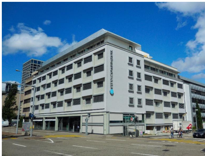
Bildtext: Die ersten Mieter sind bereits eingezogen. (Copyright: PORR)
